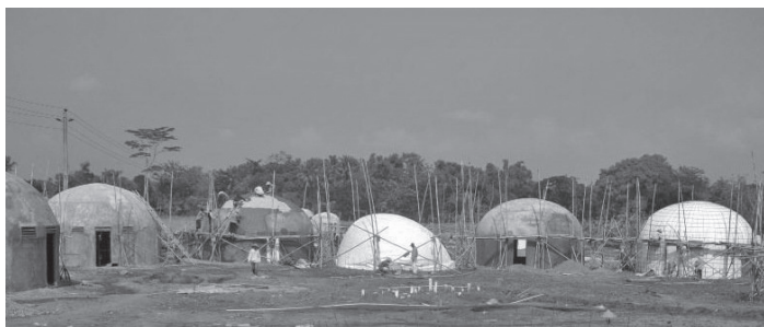
図22 建設中のドーム・ハウス 文 13)
