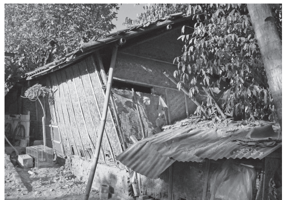
図17 被災直後の竹製の仮設住宅
