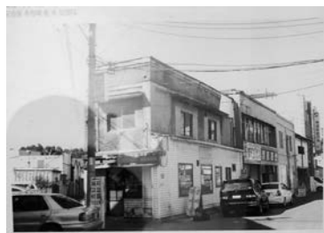
改修前の様子。東道路側の軒下部分が広がられている
