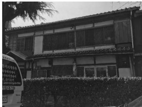
図 17 鎮海の沿道建築 木造長屋建て町家
