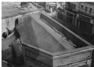
改修前の屋根の様子
