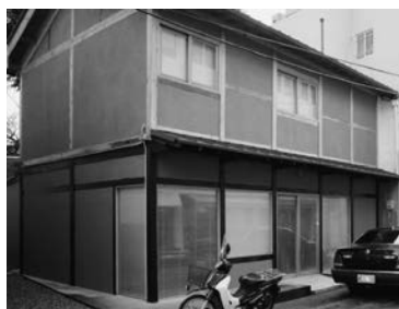
リノベ事業による他事例。架構を組み直している⑨
