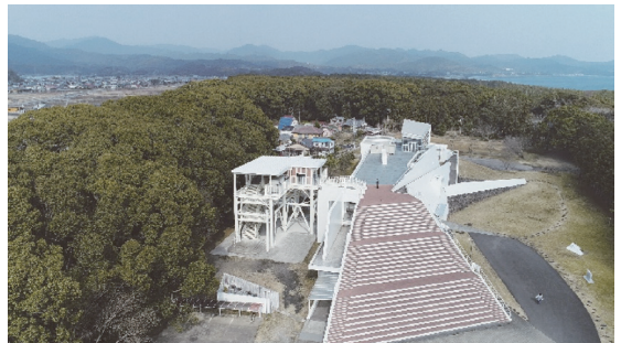
大方図書館併設の浜の宮地区津波避難タワー
