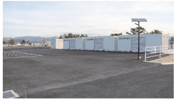
コンテナ倉庫
