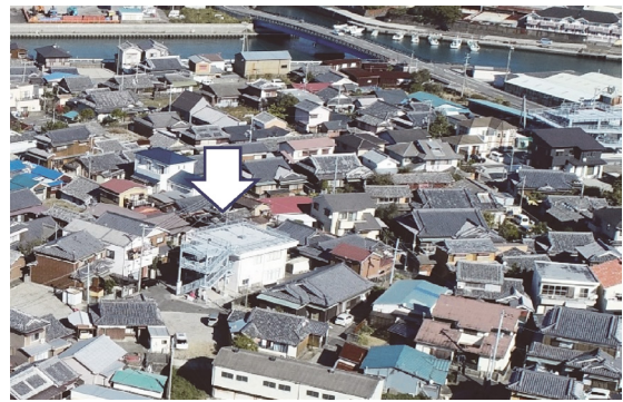
浜ノ瀬区津波避難タワー（公民館隣接）
