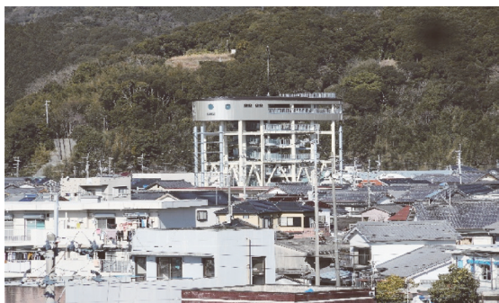
佐賀地区の住宅地と津波避難タワー（同上）
