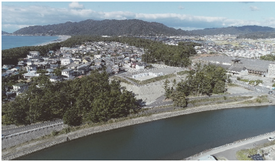
松原地区高台津波避難場所
