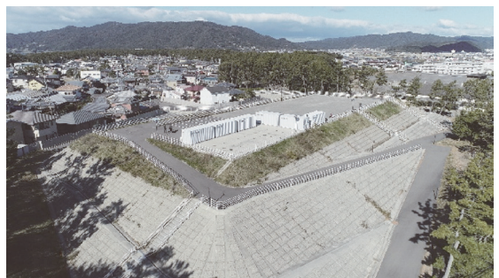
松原地区高台津波避難場所
