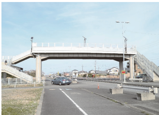
横断歩道橋型の津波避難タワー B
