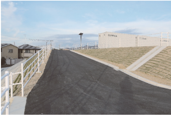
登り口とコンテナ倉庫（撮影、2018年）
