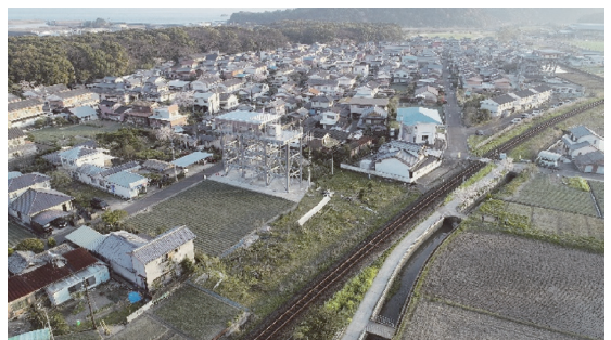
町地区津波避難タワー
