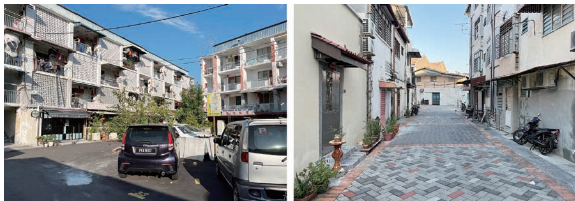
図 18：ピーポーズ・コートの外観（左）・レンガ張りの敷地内3裏路地（右）
