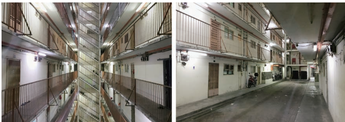
図 30：ライフル・レンジ中間階と中央階段（左）・地階のコンクリート張りのコートヤード（右）
