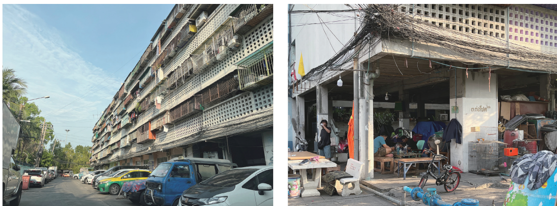
図 45：No. 18 棟外観（左）・No. 18 棟のピロティ部分（右）
