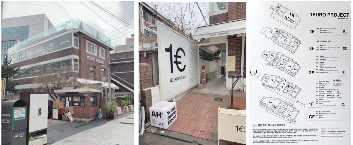
図 10 1€プロジェクト拠点施設外観とプラン
