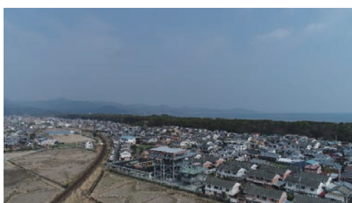
写真 4.15 万行地区津波避難タワー
