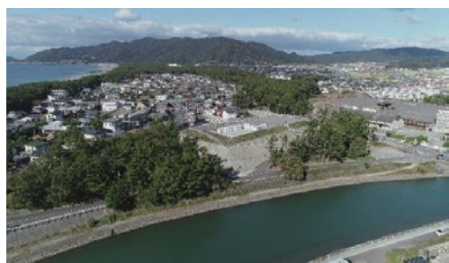
写真 4.31 松原地区高台津波避難場所
