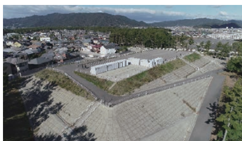
写真 4.30 松原地区高台津波避難場所（A）
