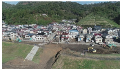
写真 4.9 東日本台風による冠水被害後（2019 年 10 月）
