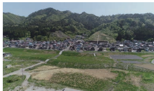
写真 4.8 完成した高さ 6.5 m の土盛り堤防（同年 5 月）
