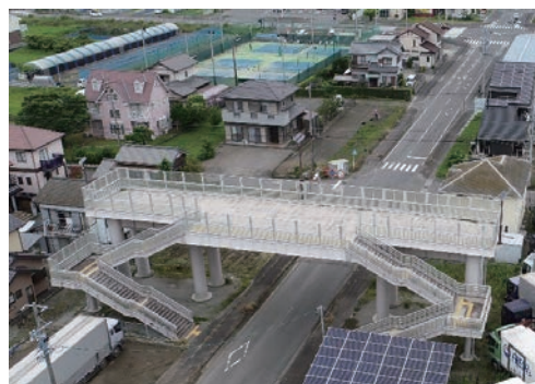
写真 4.44 横断歩道橋型の津波避難タワー A
