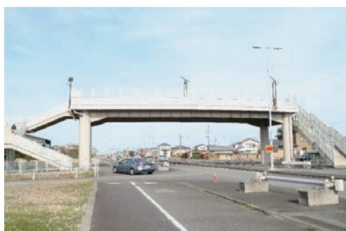
写真 4.45 横断歩道橋型の津波避難タワー B
