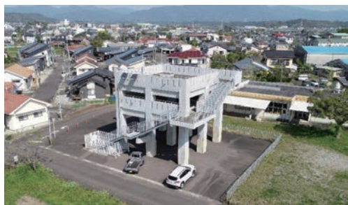
写真 4.47 宮崎県高鍋町蚊口の閉鎖型津波避難タワー
