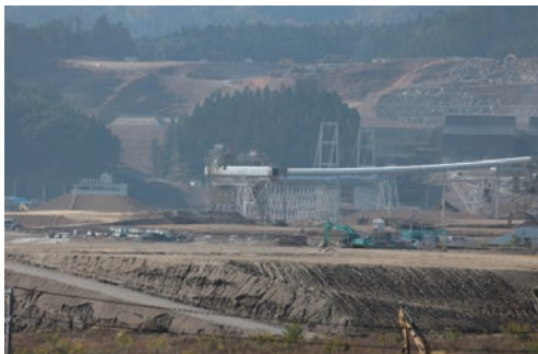
写真 4.3 山から土砂を運搬するベルトコンベヤー (2014 年)
