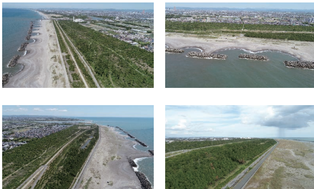
写真 4.35～写真 4.38 浜松市の沿岸域防潮堤「緑の防潮堤」
