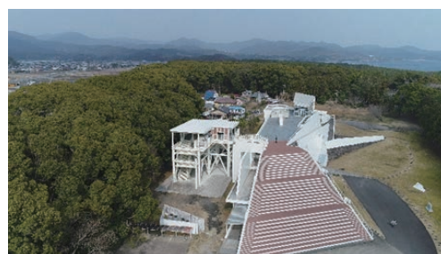
写真 4.16 大方図書館併設の浜の宮地区津波避難タワー
