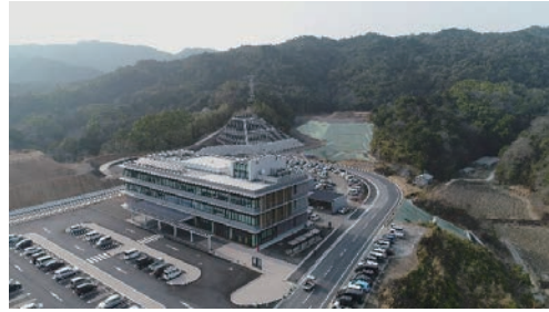
写真 4.22 黒潮町役場の新庁舎（撮影、2018年）
