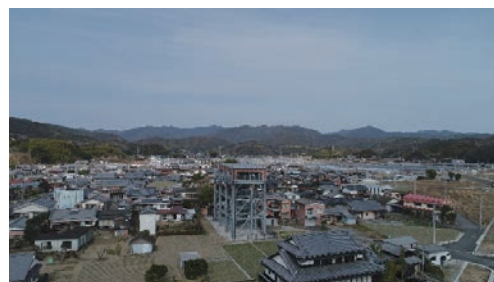
写真 4.18 早咲地区津波避難タワー
