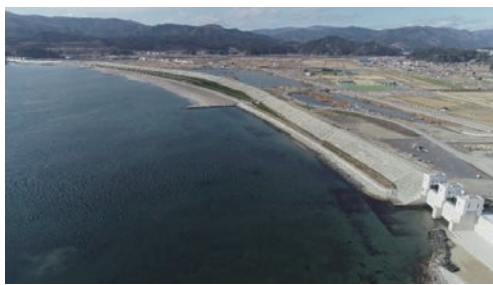
写真 4.1 陸前高田市中心部・高田地区の巨大防潮堤
