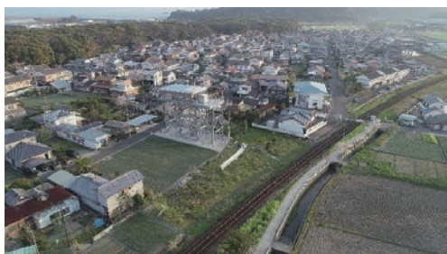
写真 4.17 町地区津波避難タワー
