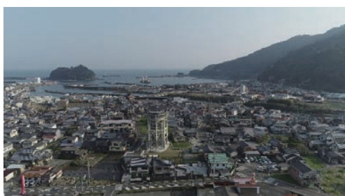
写真 4.19 佐賀地区と津波避難タワー（撮影、2019年）
