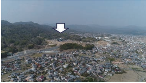
写真 4.21 高台移転した黒潮町役場
