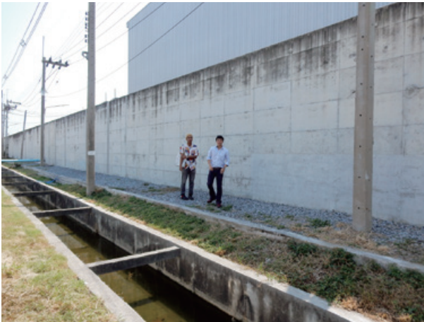
写真2. 工業団地内の工場の遮水壁と排水路
