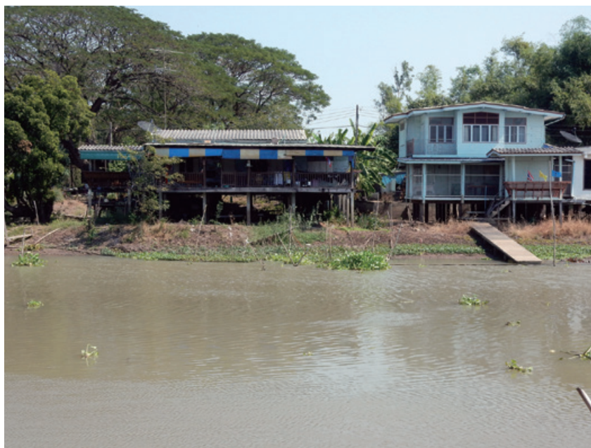
写真1. アユタヤ近郊の高床式住宅
