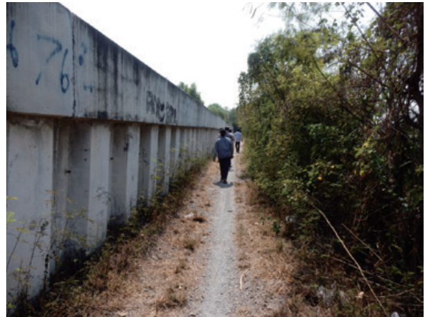
写真3. 工業団地を囲む輪中堤と遮水壁
